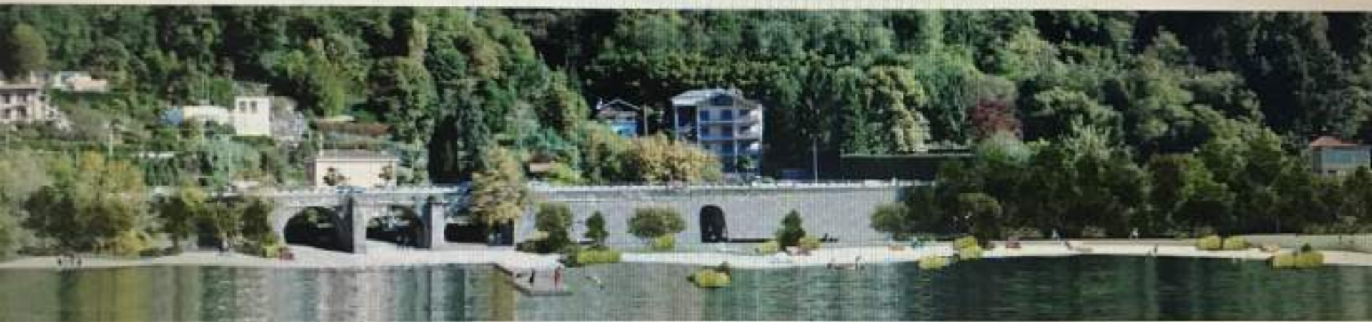
Veduta complessiva dell'intervento alla spiaggia Tre Ponti
